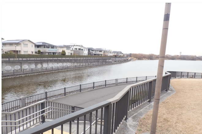
⑲ 調節池からの排水路
